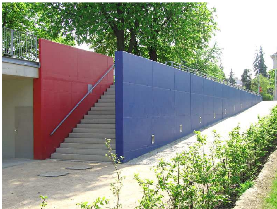
Stěny kavárny, park na Slovanském náměstí, Brno, zdroj: www.brno.cz
